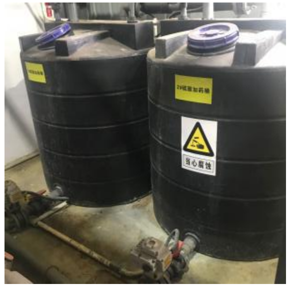
污水处理站地面防渗
