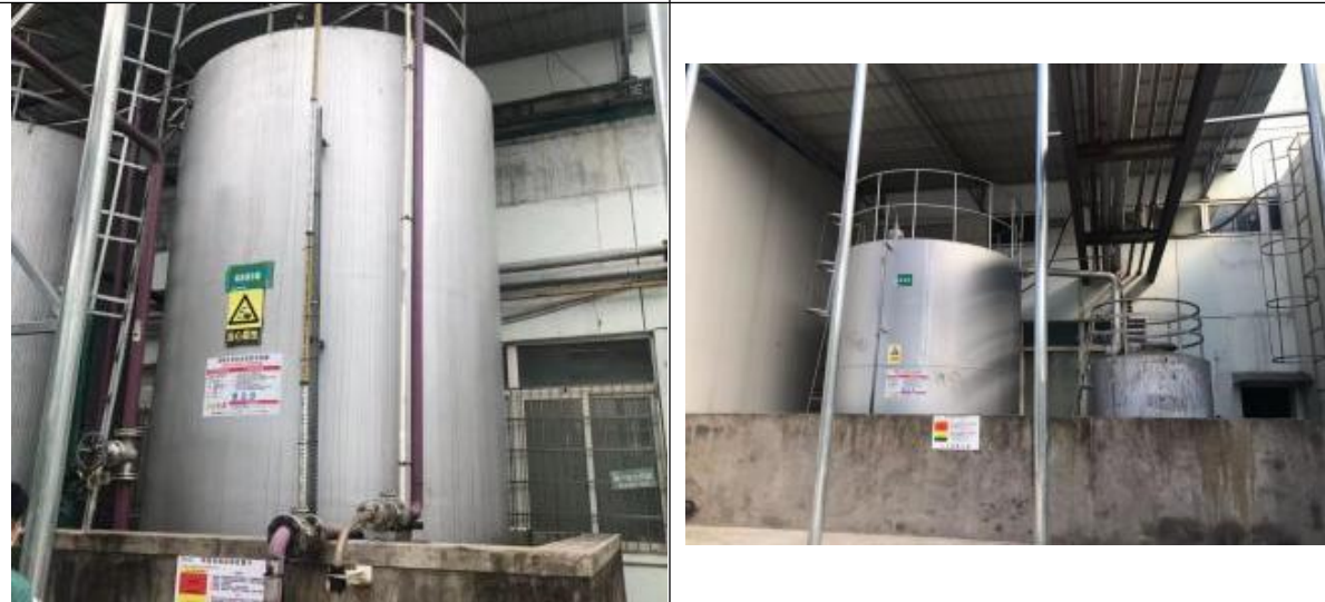
碱液储罐围堰
