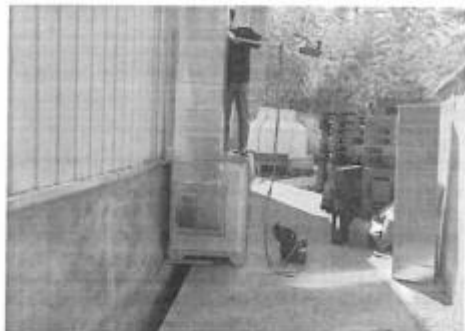
A 1 蒸馏冷凝废气排气筒进口检测
